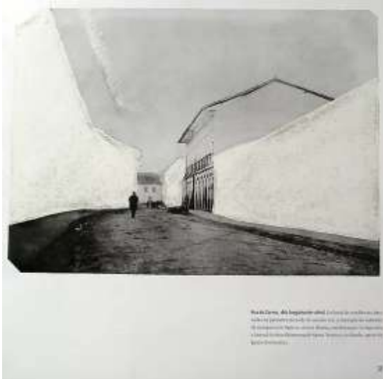
Rua do Carmo, 1862
